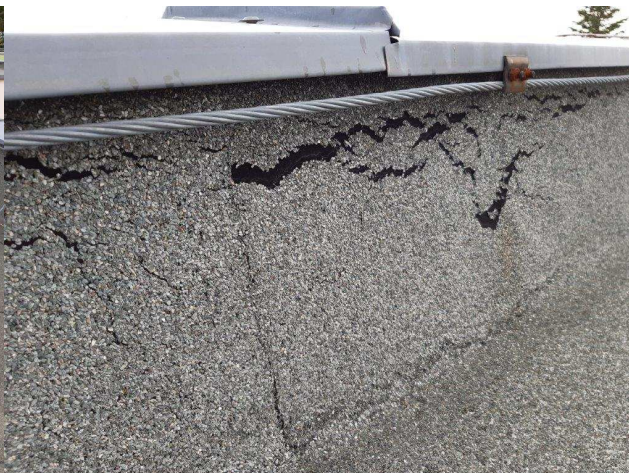
Foto 6 – sjíždění břidličného posypu
