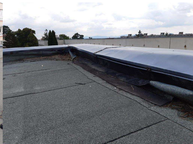
Foto 4 – odtržený asfaltový pás
